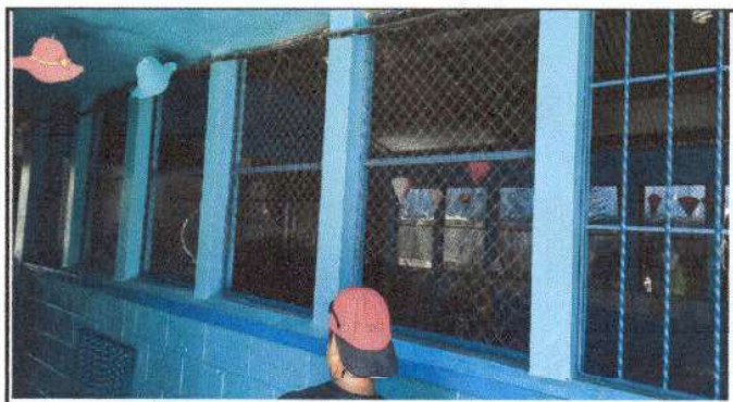
SUSTITUCION DE BALCONES DE METAL
