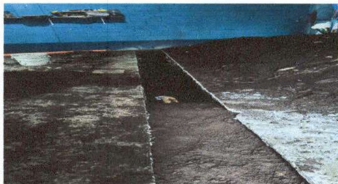
SUSTITUCION DE TUBERIA DE AGUAS NEGRAS
