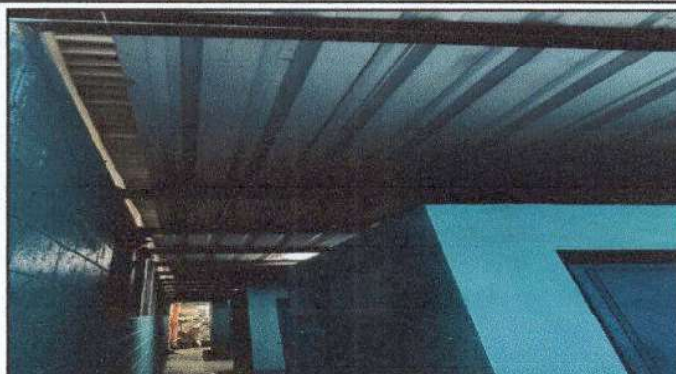
TECHO DE BAÑOS
