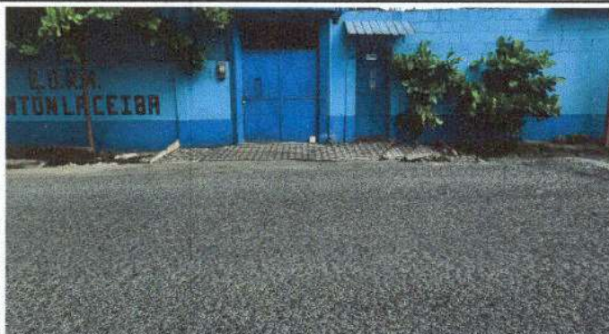
SUSTITUCION DE BARANDA DE METAL DE SEGURIDAD Y PLANCHA DE CONCRETO EN EL INGRESO DEL ESTABLECIMIENTO
