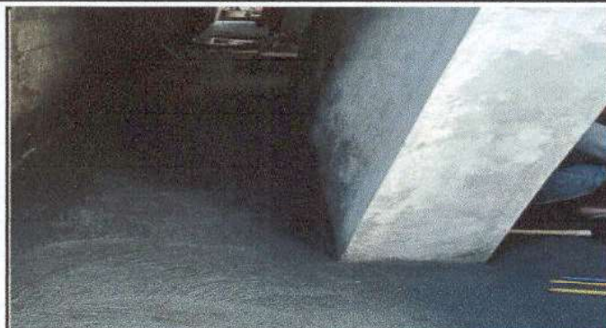
SUSTITUCION DE AZULEJO
