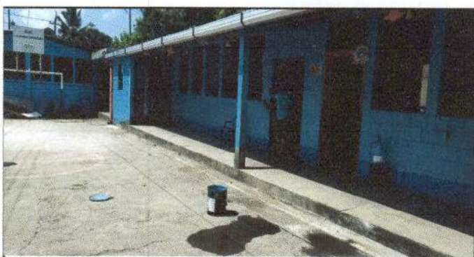
PINTURA DE MUROS EXTERIORES E INTERIORES
