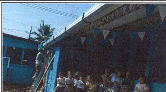
SUSTITUCION CANAL DE METAL
