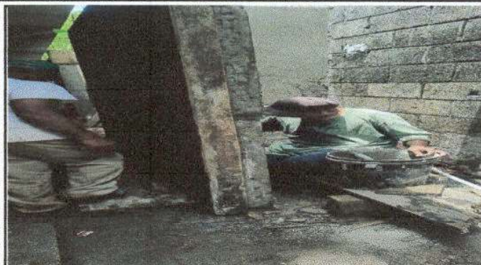
REPELLO DE PAREDES DE LOS BAÑOS
