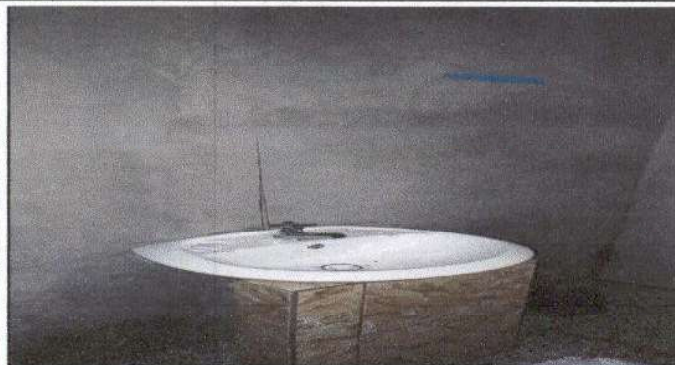
SUSTITUCION DE LAVAMANOS
