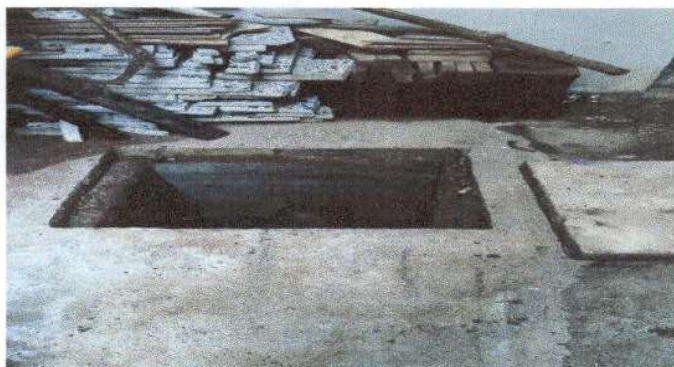
SUSTITUCION DE CAJA DE REGISTRO
